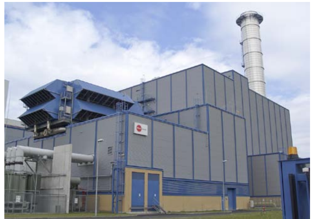
Das bestehende Heizkraftwerk der Rheinenergie in Köln-Niehl – das GuD-Kraftwerk liefert Strom und Fernwärme für die Kölner Innenstadt. Foto: Rheinenergie
